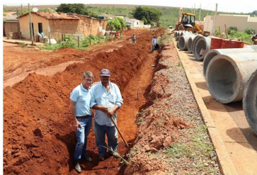
MELHORIA DA INFRAESTRUTURA
